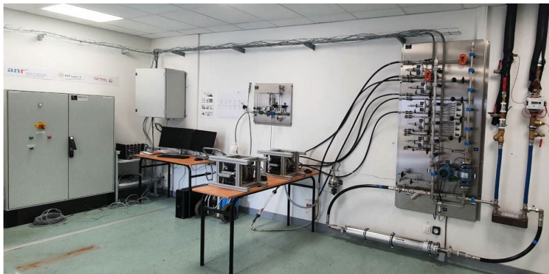
banc d'essai en cours de construction
