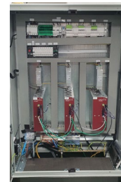
test-contrôleur MOOG et armoires électriques
